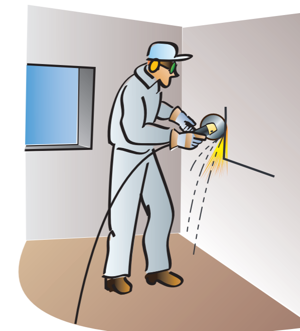
Skæring med vinkelsliber i bygningsdele af murværk eller beton kan være varmt arbejde
